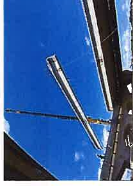
PC橋架設工
