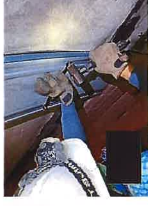
トンネル漏水対策工
