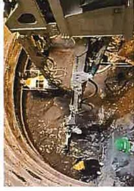
トンネル工（NATM）〔発破工法〕
