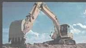
建設現場 重機を遠隔操作し、省人化と効率化を実現
